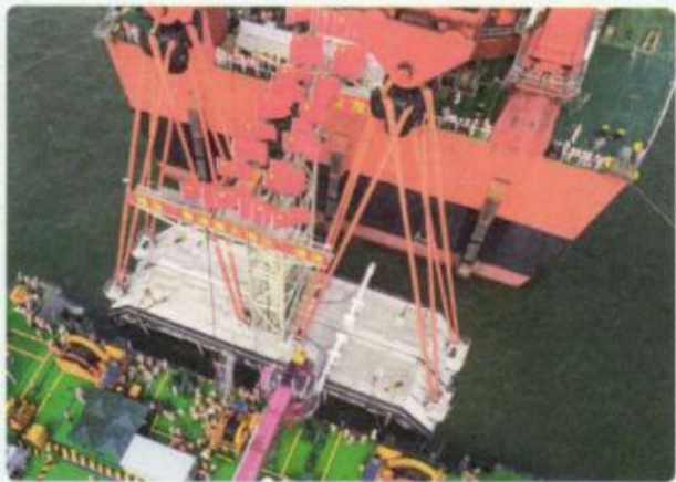
港珠澳大桥岛隧工程海底隧道的最终接头在伶仃洋主航道吊装下沉对接完成
