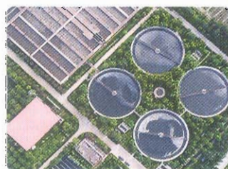
城市生产生活污水处理厂
